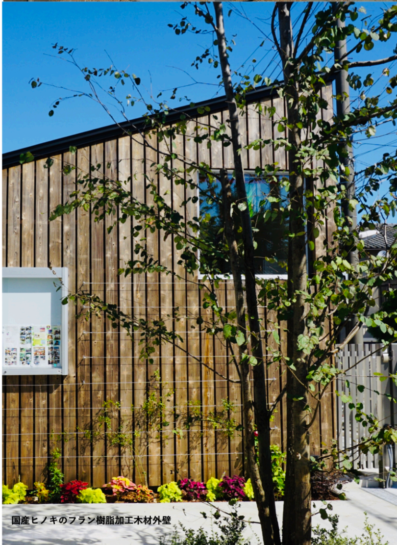
国産スギのフラン樹脂加工木材外壁 武庫川の住居 設計：タトアーキテクト (Tato Architects / Yo Shimada)
